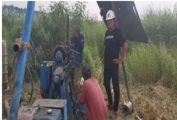
Gambar 4. Pengujian bore log di Lapangan
